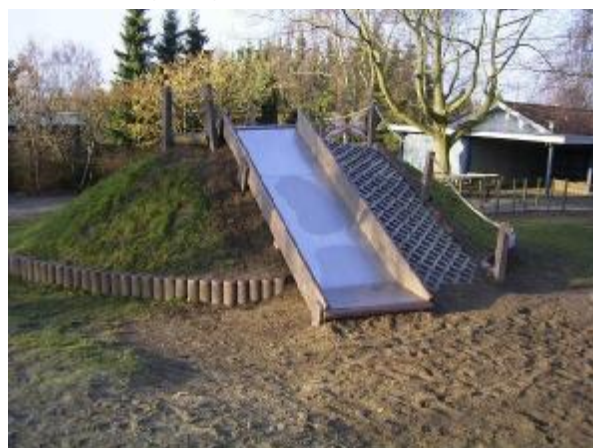
Rutschebane 5 x 1 meter - nymonteret og klar til nedlægning af klatreelementer
