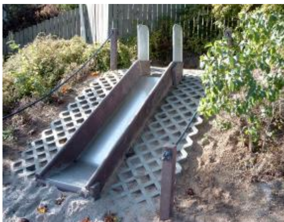
Rutschebane 2,5 x 0,6 meter - selvfølgelig monteret med korrekt startflade og udløb
